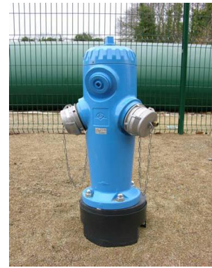
Poteau d'aspiration de 150 mm muni de deux sorties de 100 mm et d'un carré de manœuvre
