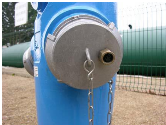
Poteau d'aspiration de 150 mm muni d'un Airclap
