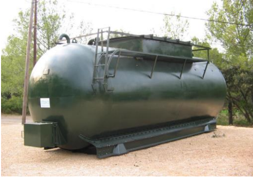
Réserve d'eau incendie aérienne type citerne 30 m 3 , équipée d'une sortie de 100 mm
