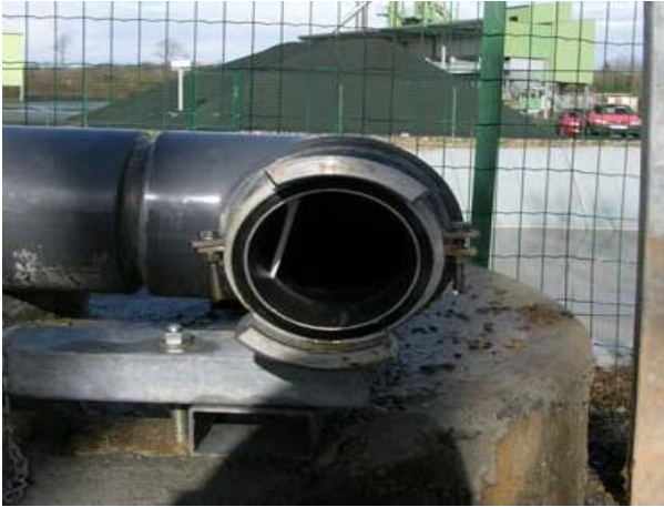
Une sortie de 100 mm avec les tenons verticaux (l'un au dessus de l'autre)
