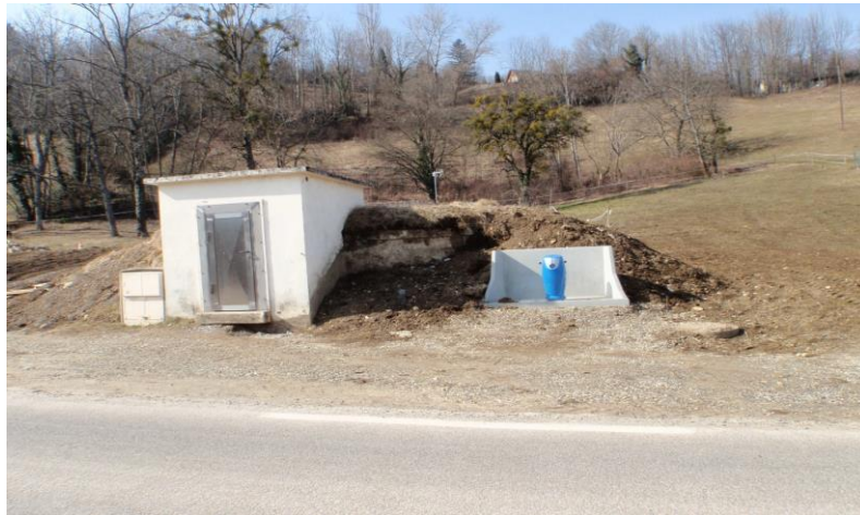
Aménagement de réservoirs artificiels
