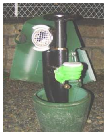
Intérieur d'une borne de puisage avec ½ raccord de 65 mm et compteur d'eau
