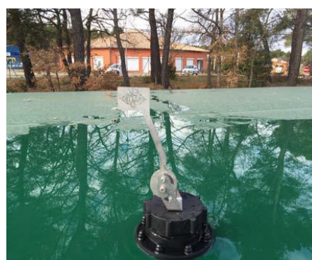
Drapeau indicateur de remplissage relié via une poulie à une sonde lestée
