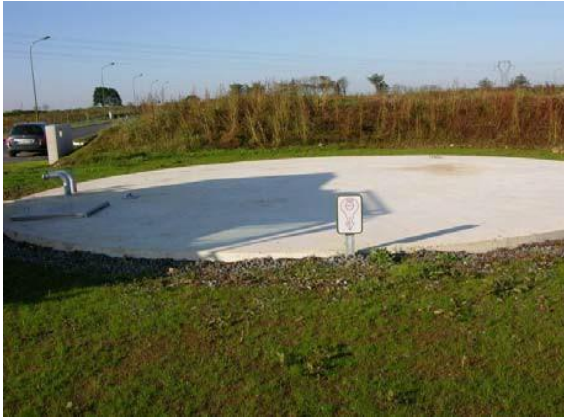
Réserve d'eau enterrée
